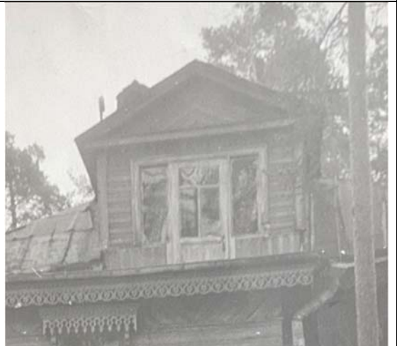
мезонин на северном фасаде
