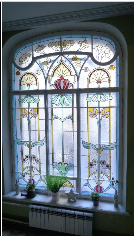
окно на площадке 2-3 этажей
