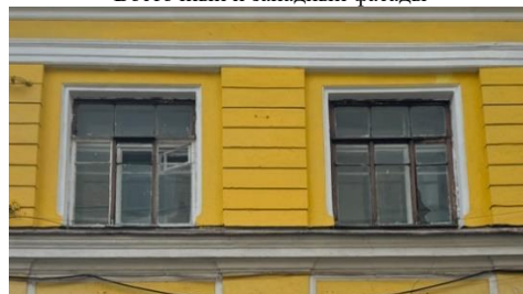
Северный и южный фасады
