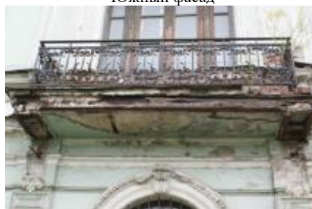
Балкон южного фасада
