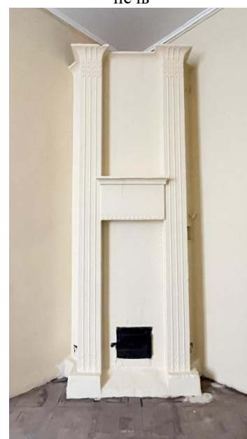
второй этаж, помещение (21-Н) 53, печь
