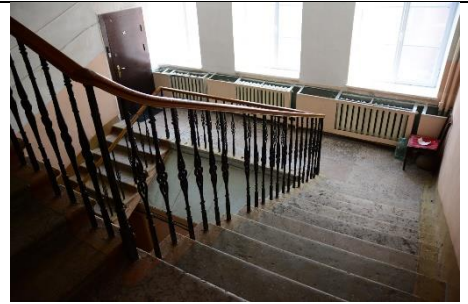
северо-восточная часть здания, лестница Л-2
