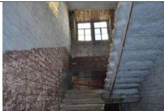
лестница 2ЛК. Фото 2015 г.
