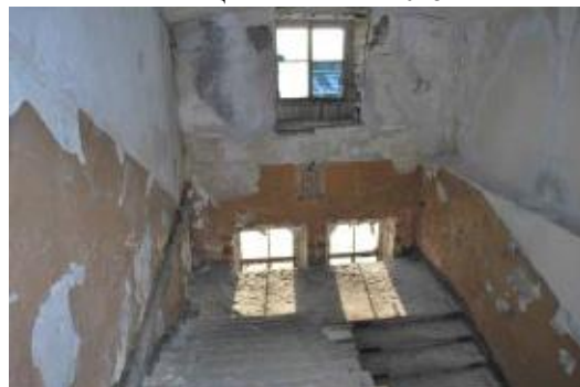
лестница 3ЛК. Фото 2015 г.
