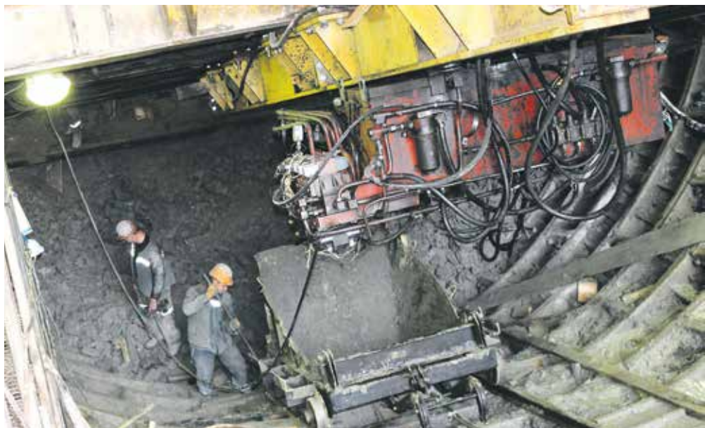
Идет активное строительство будущей станции метро «Юго-Западная»
