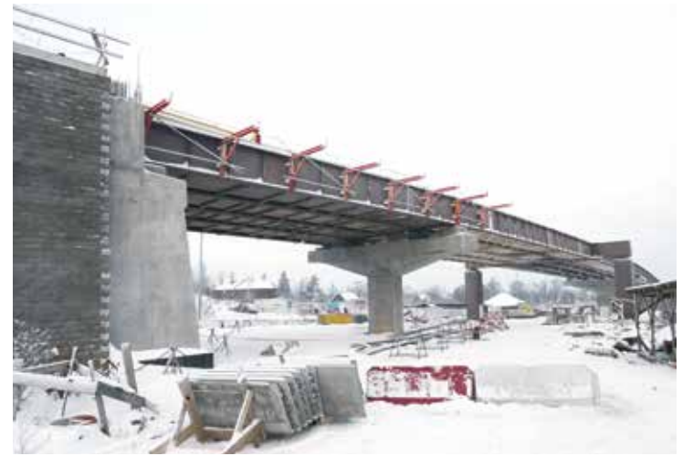
Строительство путепровода транспортного обхода Красного Села
