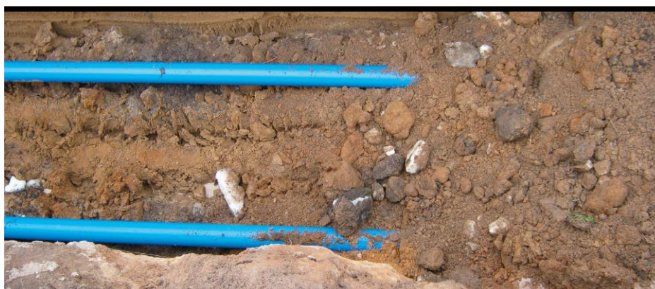
Укладка труб ARP с обратной засыпкой грунта
