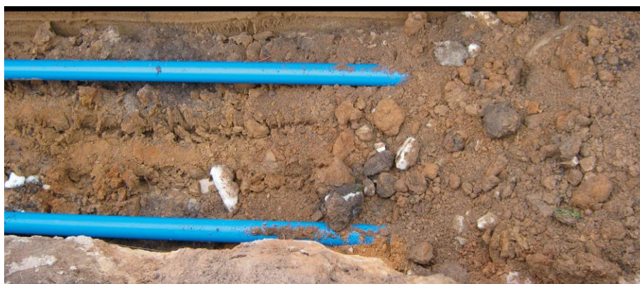
Укладка труб ARP с обратной засыпкой грунта
