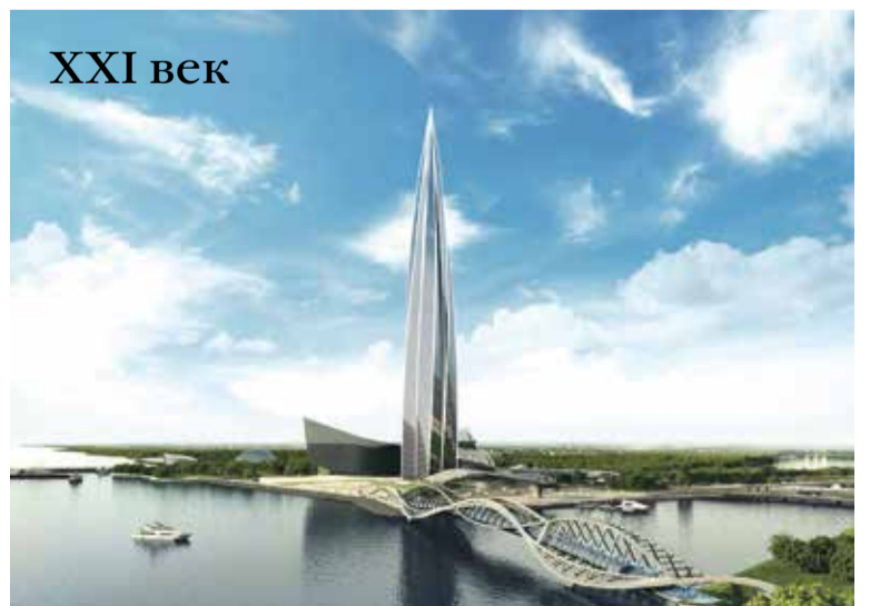
Будущий Лахта-центр – новое для города слово в архитектуре, строительных технологиях, градостроительной политике. В прежде пустой Лахте небоскреб уже сейчас создает новый деловой и культурный центр Петербурга
