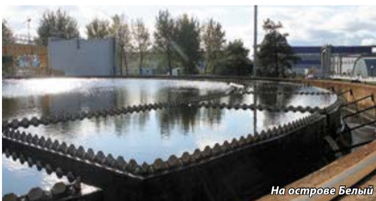
На строительстве ЗСД
