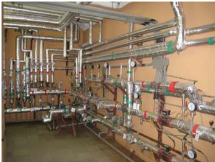
Рис. 1. Пример индивидуального теплового пункта с САПР
